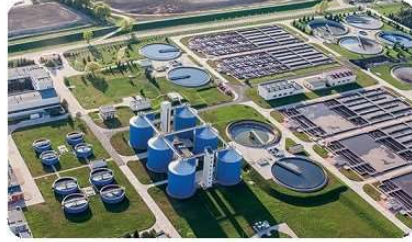
Su arıtma tesisi
